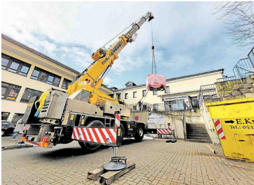
Per Kran wird das mehrere Tonnen schwere neue MRT-Gerät an seinen Bestimmungsort transportiert.
