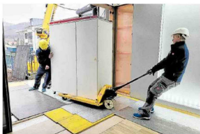
Unter großem Kraftaufwand und über ein aus Platten errichtetes Podest ziehen die Mitarbeiter der beauftragten Logistikfirma einen der Schaltschränke ins Gebäude.
